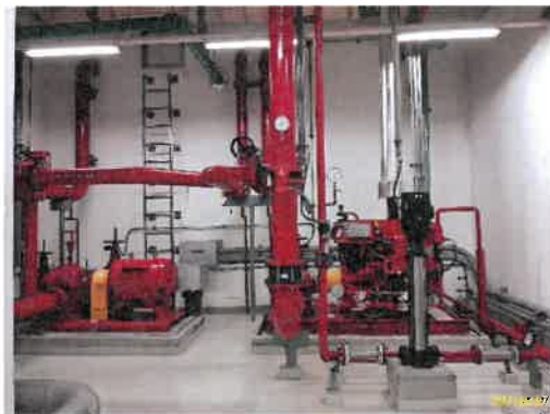
ปั๊ม และถังเก็บน้ำสำรองเพื่อการดับเพลิงชั้นใต้ดิน
