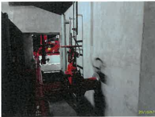
ปั๊ม และถังเก็บน้ำสำรองเพื่อการดับเพลิงชั้น 42M
